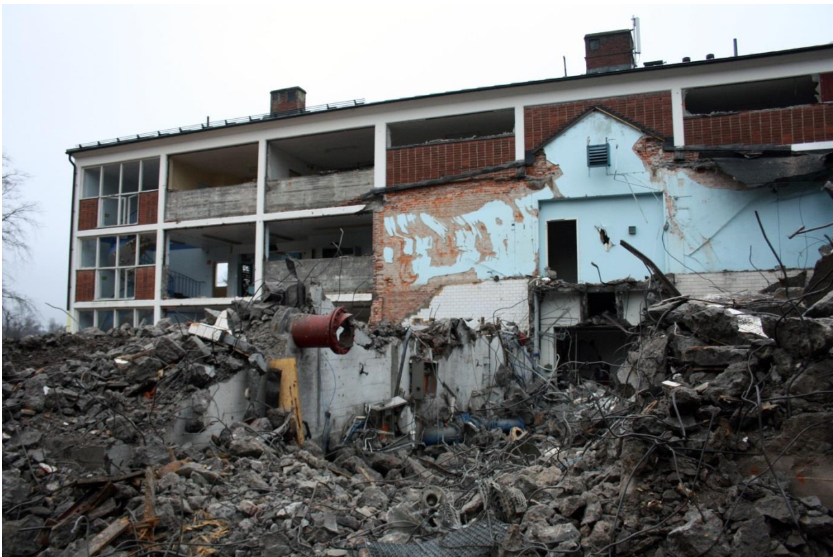
Bild tagen i samband med rivningen av vattenverket under hösten 2012. Foto: Samuel Palmblad
